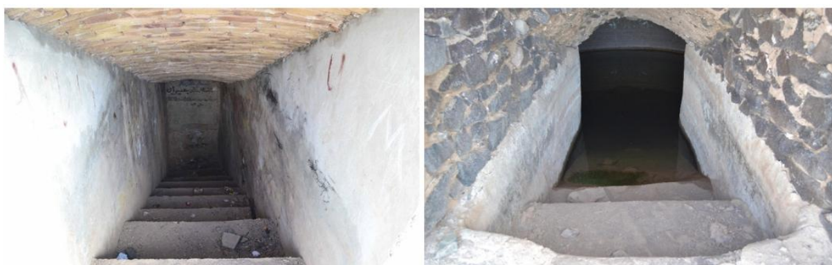
شکل ۴. دو نمونه از درگاه‌های ورودی آب‌انبار به‌صورت پاشیردار الحاقی در سمت چپ و بدون پاشیر قدیمی در سمت راست (Authors, 2025)
