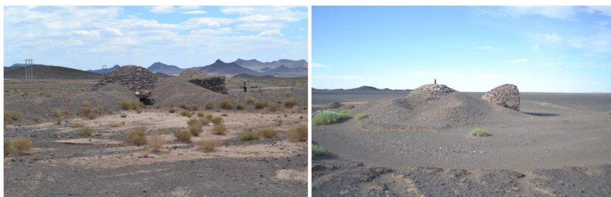
شکل ۳. دو نمونه از آب‌انبارهای گنبدی لاشه‌سنگی خوسف (Authors, 2025)
