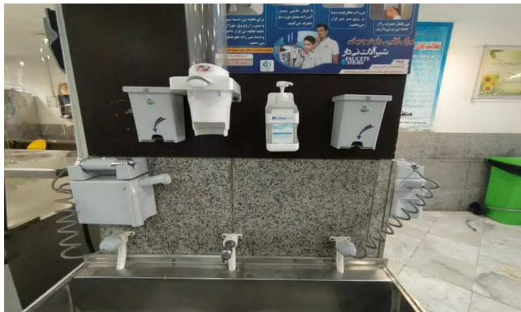
شکل ۷- تعویض سر شیرهای آب سرد کن‌های سالن‌های غذاخوری دانشجویی به منظور جلوگیری از افزایش مصرف آب و کاهش استفاده از لیوان یک بار مصرف
