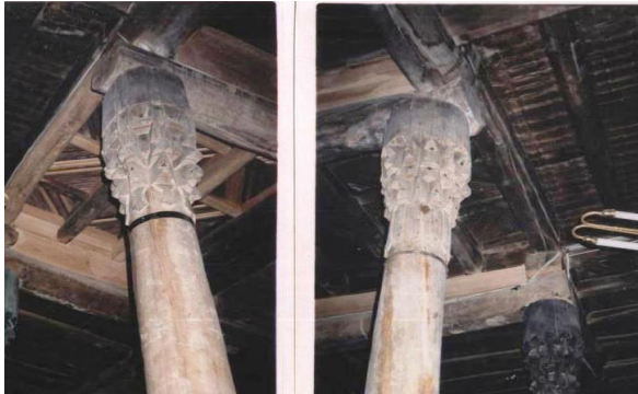
تصویر ۴: نمای ستون و سرستون و پردوهای مابین آن، (مأخذ: نگارنده).
